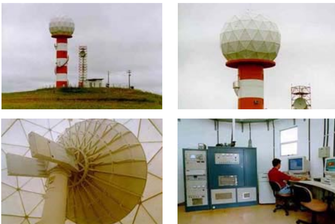
Fotografia 7.1 – Radar meteorológico do SIMEPAR – Torre, Radome, Antena e Sala de Controle – Teixeira Soares – PR.
